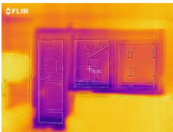
Slika 18: Balkonska vrata in okno
